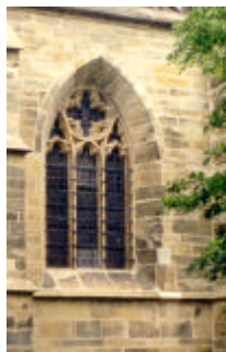
Rechtes Fenster in der Ostwand mit der original Vergitterung
