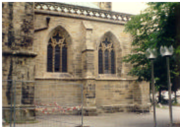
Die Südseite des Scriptoriums mit den großen Fenstern, die Maßwerkbrüstung und die Maßwerkfenster wurden im 19. Jahrhundert erneuert, die Fenstergitter sind original.
