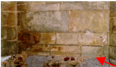
Pfeil zeigt die ehem. Steintischoberkante an der Ostwand
