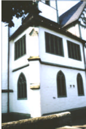
Aussenansicht Nordseite Chorraum
